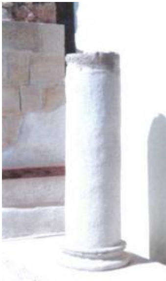
<30> Заполнение пустот в колоннах каменными «отливками»
