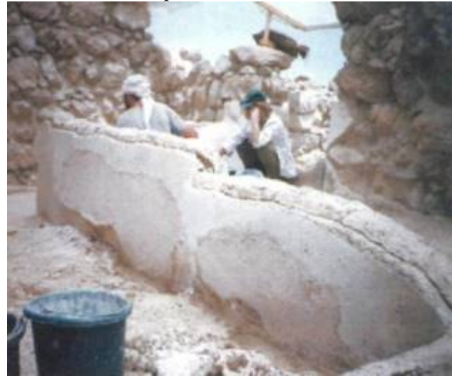
<22> Легкий ремонт глинобитной конструкции: восстановление штукатурки и наложение «разового» защитного покрытия
