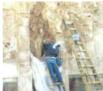
<25> Заливка трещин земляным раствором
