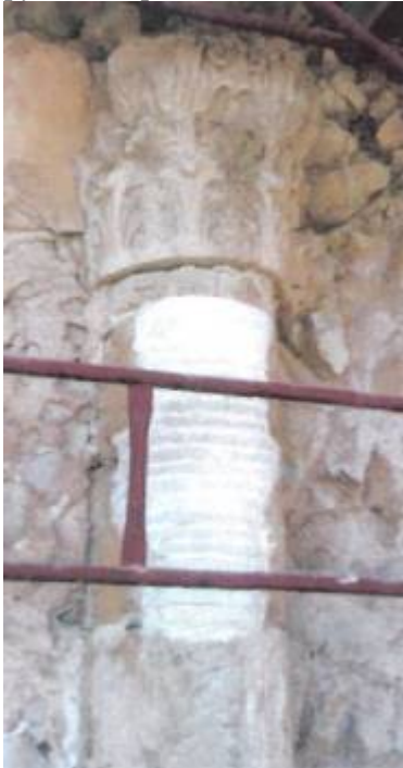
<30> Заполнение пустот в колоннах каменными «отливками»
