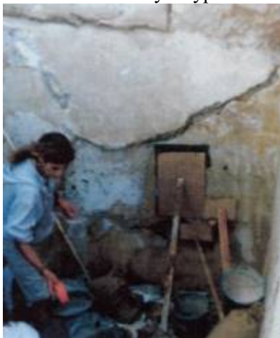
<11> Консервация известкового штукатурного покрытия
