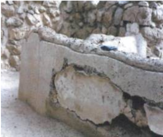
<21> Тяжело поврежденная стена из глинобитного кирпича с глинистым покрытием
