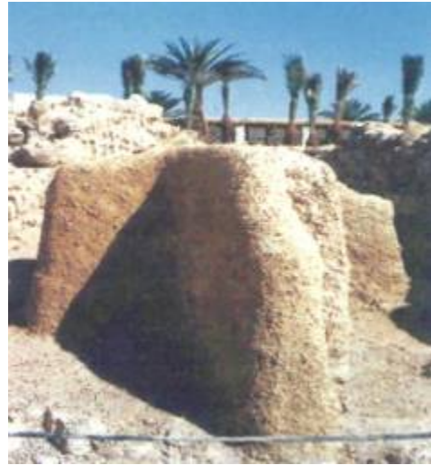
<22> Легкий ремонт глинобитной конструкции: восстановление штукатурки и наложение «разового» защитного покрытия
